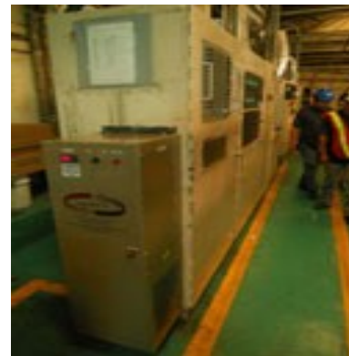
Enfriador de Aire de Tipo Vertical Instalado en Industria
